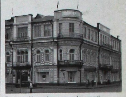
Городская Управа (комплекс из 4-х зданий), Коммунистическая ул., 51, 53, 55 (5/2)
